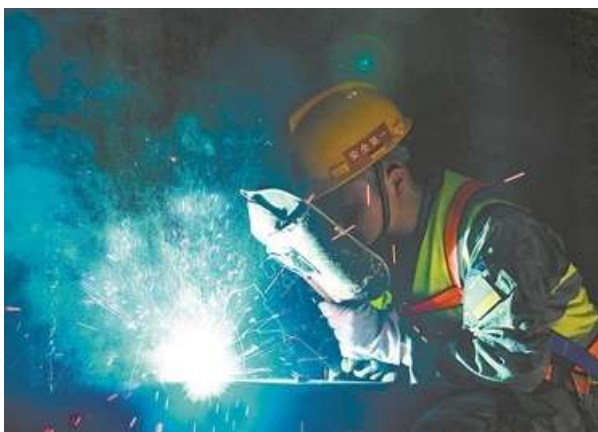
溶接をするロケット軍工兵
